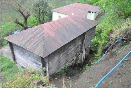
Resim 212: Hakkı Bektaş Tekiri Kıрма Çatısı
