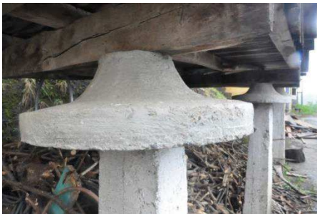
Resim 54: Şevki Bektaş Tekiri Beton Ayağı ve Aşağı
