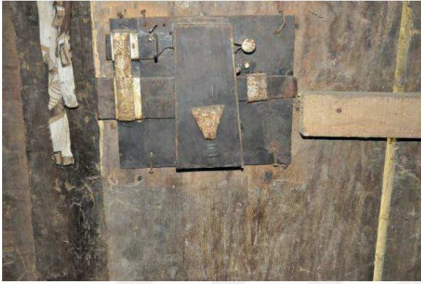
Resim 331: Mustafa Özdin Tekiri Demir Kilit Sistemi
