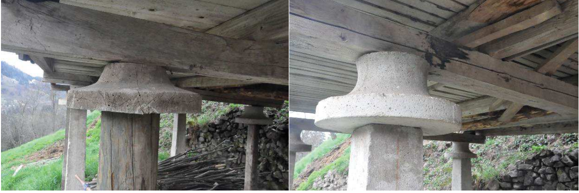
Resim 87:Mehmet Erata Tekiri Ahşap ve Beton Ayak ve Aşakları
