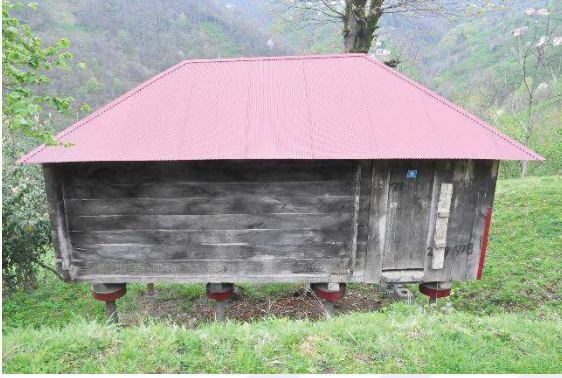
Resim 383: Örtü sisteminde çinko ve boya kullanımı
