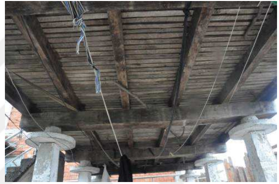
Resim 195: Mustafa Yaşar Tekirinin Uzunlukları Üzerine Aralıklı Döşenmiş Zemin
