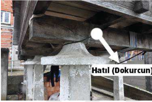
Resim 352: Ayağın Üzerine Atılmış Hatıl (Dokurcun)
