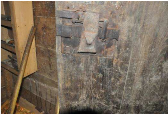
Resim 344: Mican Karaca Tekiri Kapı Kanadındaki Demir Kilit Sistemi
