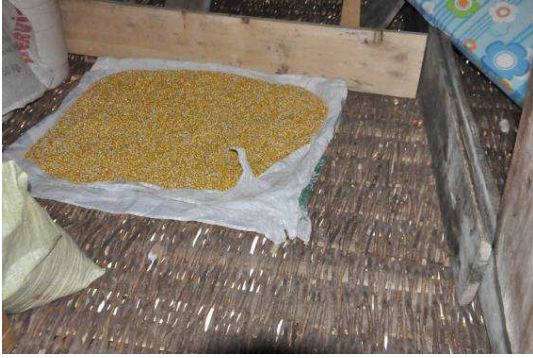
Resim 156: Sadık Köse Tekiri Komar Ağacı Dallarıyla Örülmüş Ana Mekan Bölümü Zemini ve Serili Duran Mısır Taneleri
