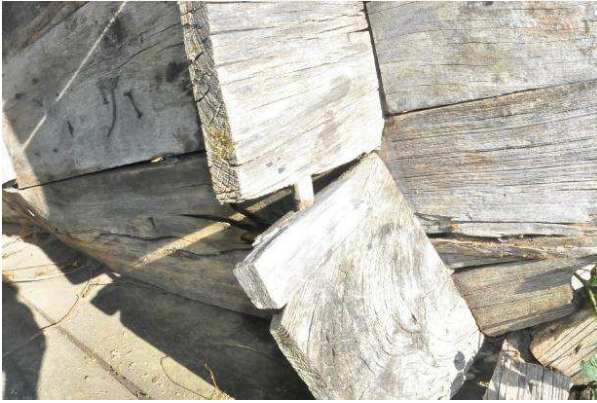
Resim 72: Akçiriş 21 Kapı Numaralı Tekirin Tahta Duvarlarına Uygulanan Ahşap Çivi Detayı
