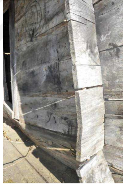
Resim 71: Akçiriş 21 Kapı Numaralı Tekirin Tahta Duvarlarına Uygulanan Ahşap Çivi Detayı
