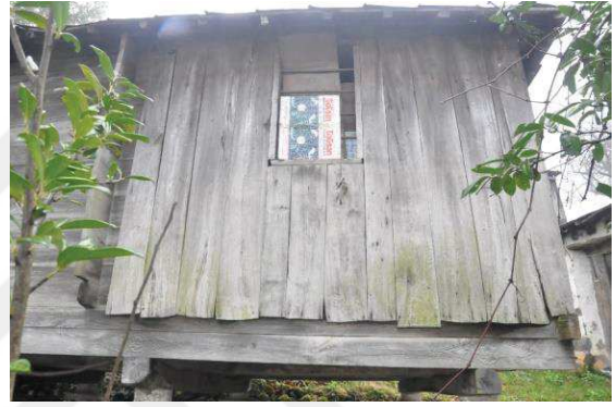
Resim 247: Tepeağı 74 B Kapı Numaralı Tekirde Balkonu Kapanan Tahtalar Çivilerle Tutturulmuş
