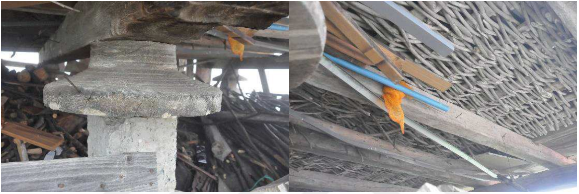
Resim 139: Efendioğlu Murat Tekiri Ahşap Aşağı ve Komar Ağacı Dallarından Örölmüş Zemin Döşemesi
