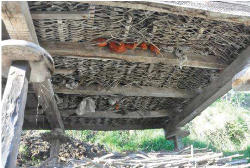
Resim 356: Komar dallarıyla örülmüş zemin döşemesi
