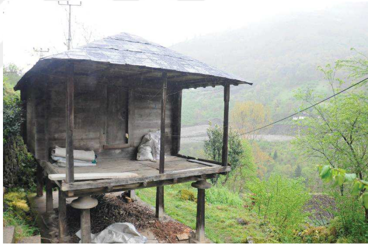
Resim 378: Duvar, balkon direkleri, kapı kanadı v.s. ahşap kullanımı
