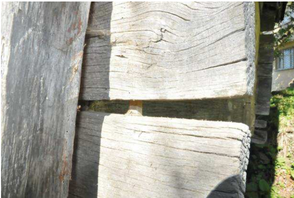
Resim 336: Ahmet Yılmaz Tekirinde Tahta Duvar Ahşap Çivi İle Sağlamlaştırılmış
