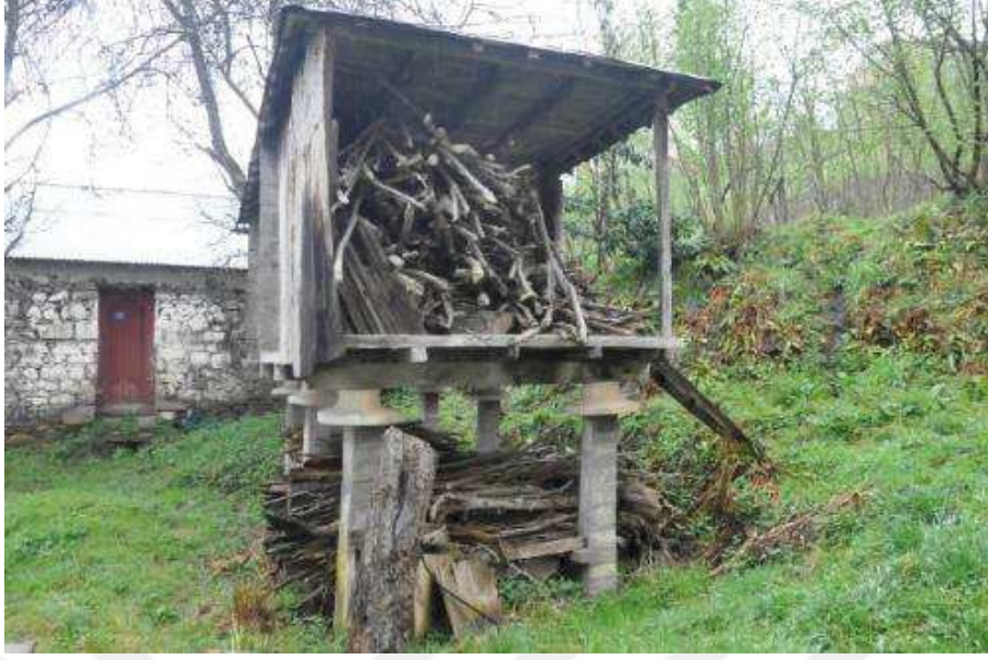
Resim 1332: Köksal Türkmen Tekiri Balkon Bölümü
