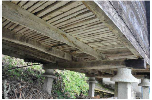
Resim 60: Ali Kandil Tekiri Aralıklı Zemin Döşemesi, Uzunlukları ve Ayaklar Üzerine Atılan Kalın Hatıllar
