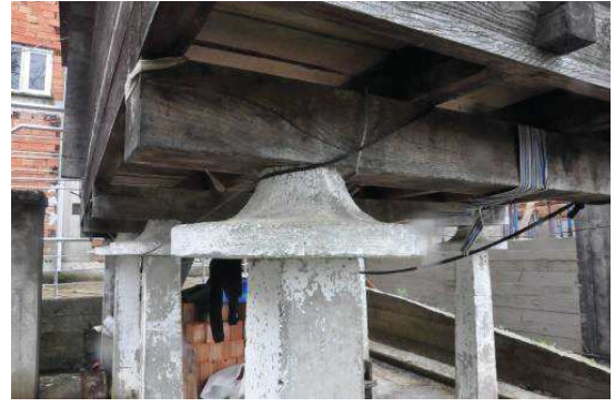
Resim 193: Mustafa Yaşar Tekiri Ayağının Üzerine Atılmış Hatıl (Dokurcun)
