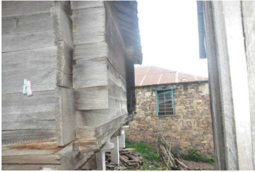
Resim 158: Mustafa Karagöz Tekiri Ahşap Geçme Tekniği
