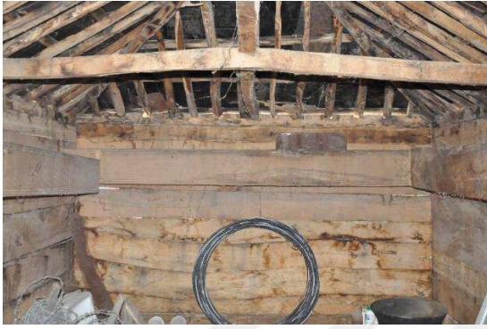
Resim 74: Şakir Usta Tekiri Ana Mekan Duvarına Asılı Duran U Şeklindeki Ambar Birimleri
