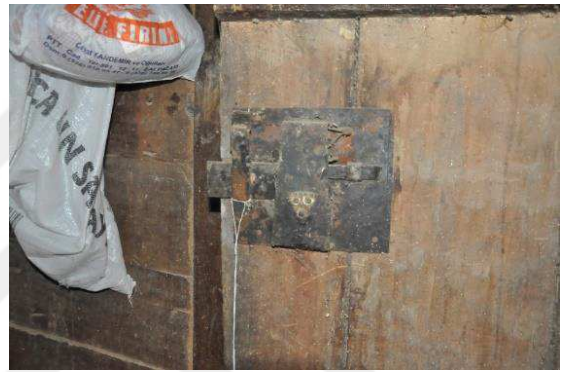
Resim 32: Kadir Akgül Tekiri Demir Kilit Sistemi
