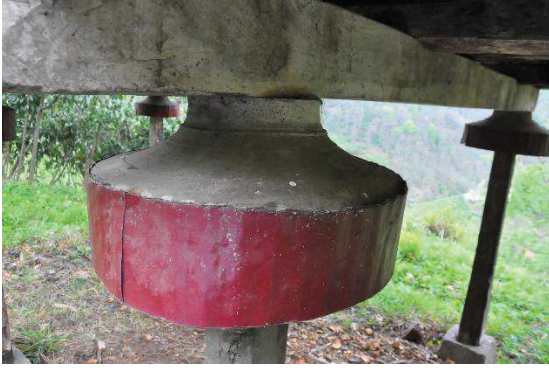
Resim 381: Aşak sac ile sarılmıştır
