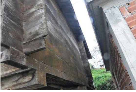
Resim 11: Kurtboğazı yani ahşap geçme tekniği
