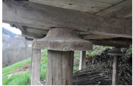
Resim 351: Ayağın üst kısmına yerleştirilmiş aşak
