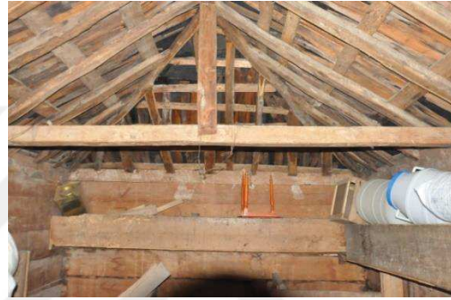
Resim 159: Mustafa Karagöz Tekiri Kıрма Çatılı Üst Örtü
