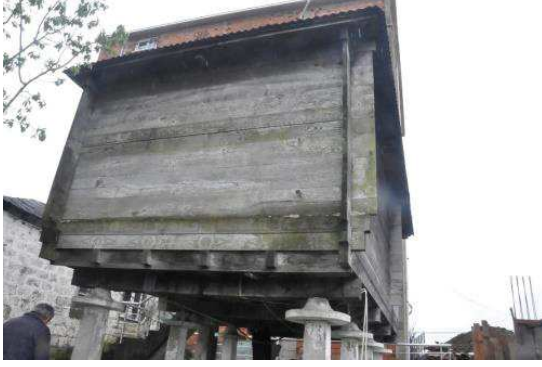
Resim 192: Kurtboğazı Tekniğiyle Yapılmış Mustafa Yaşar Tekiri
