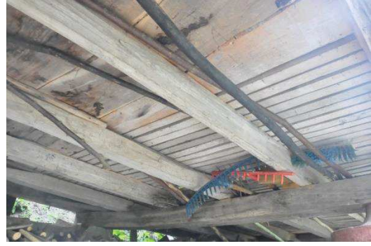
Resim 183: Hakkı Bektaş Tekiri Uzunluklarının Üzerindeki Aralıklı Zemin Döşemesi
