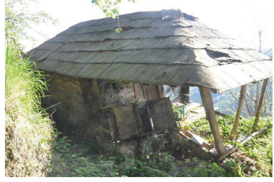
Resim 382: Örtü sisteminde teneke kullanımı
