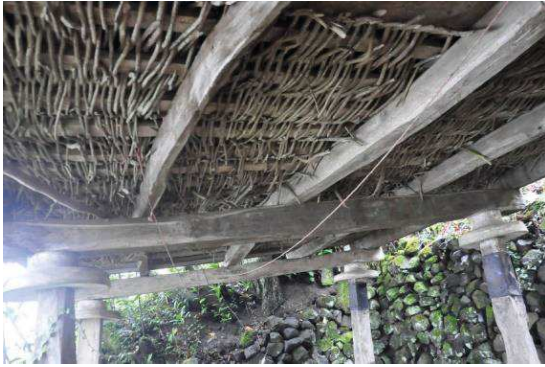
Resim 248:Tepeağı 74 B Kapı Numaralı Tekir Zemin Döşemesi
