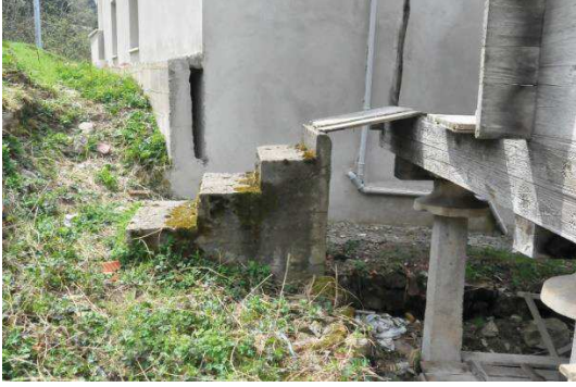
Resim 192: Mustafa Durmuş Tekiri Yapıdan Bağımsız Merdiveni ve Seyyar Tahta Köprüsü
