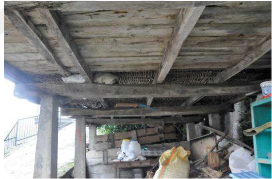
Resim 242: Mehmet Atalar Tekiri Tahta Döşeli Balkon ve Komar Dallarlarıyla Örölmüş Ana Mekan Zemini
