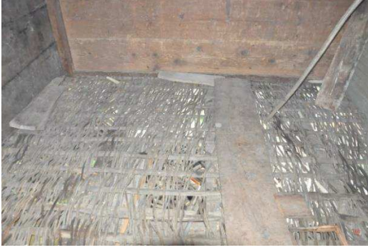
Resim 18: Bahri Metin Tekiri zemininin komar dalı örgülü döşemesi
