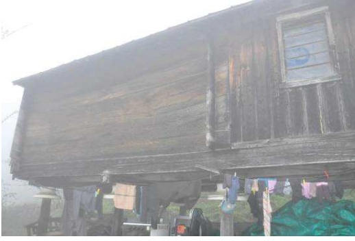
Resim 205: Sami Bayraktar Tekiri Doğu Cephesi
