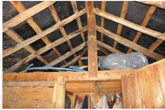
Resim 93: Mustafa Çolak Tekiri Ahşap Örtü Sistemi ve Tavan Arası Boşluğu
