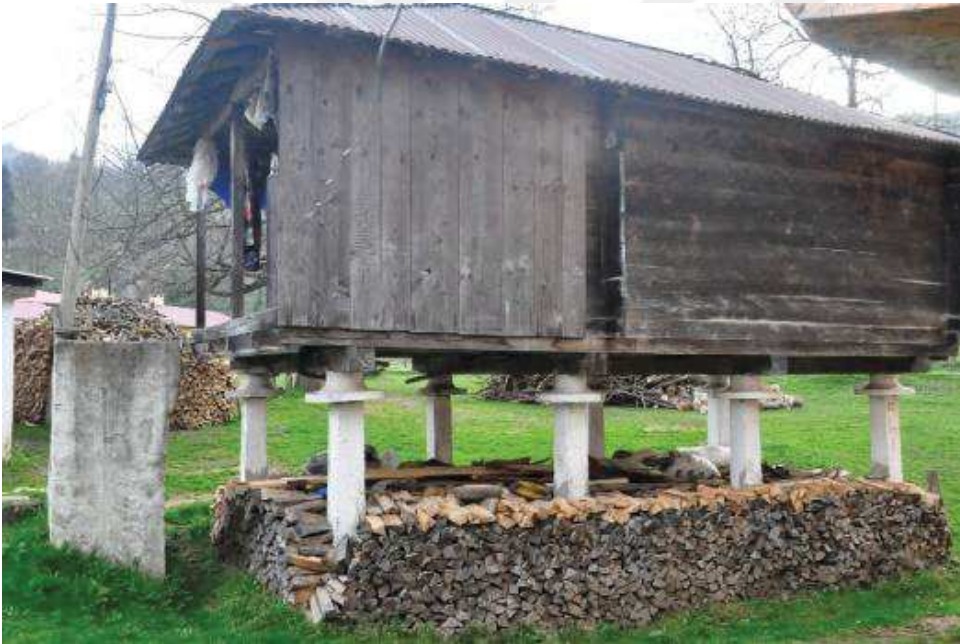
Resim 254:Hikmet Karagöz Tekiri Kuzey Cephesi
