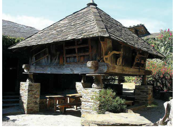
Resim 370: Ahşap horrero ve ahşap geçme tekniği 114
