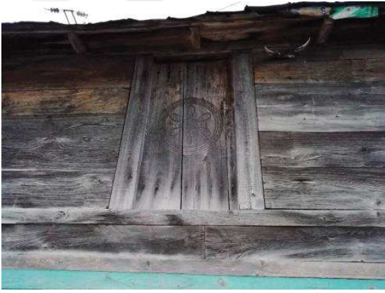
Resim 217: Hasan Koral Tekiri Güney Cephedeki Kapı
