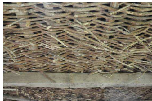
Resim 138: Tepeağzı 73 B Kapı Numaralı Tekirin Zemin Döşemesi
