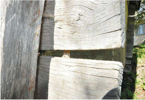
Resim 387: Kurtboğazi ahşap çivi ile sağlamlaştırılmıştır
