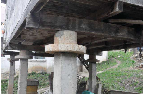
Resim 76:Kazım Söyler Tekiri Direk ve Taştan Yapılmış Aşağı
