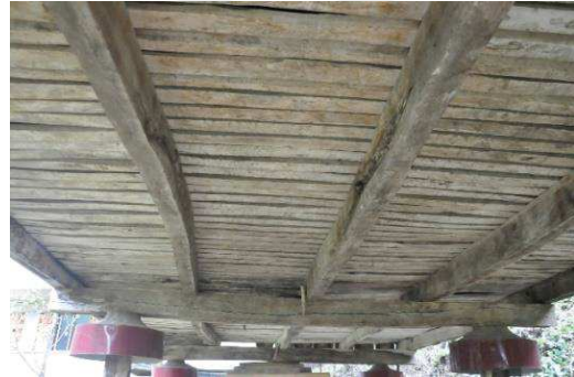
Resim 357: Ahşap ile aralıklı döşenmiş zemin
