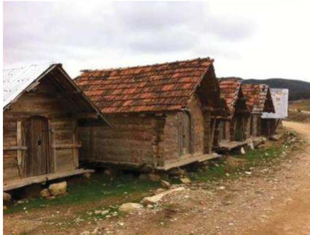
Resim 4: Uşak ilinin Banaz ilçesine bağlı Ovacık köyündeki ahşap ambarlar 91
