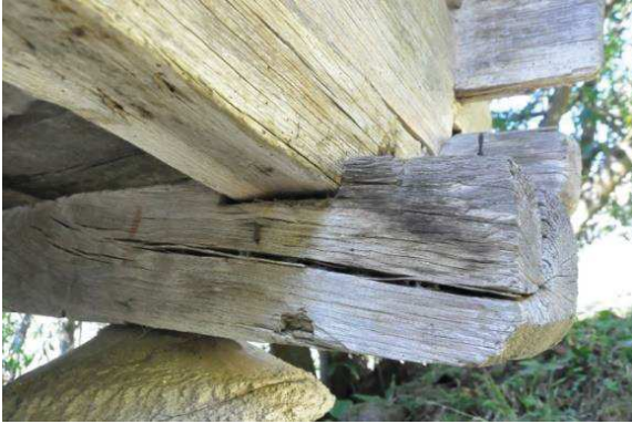
Resim 334: Ahmet Yılmaz Tekirinde Uzunluk Ağacı Hatların Üzerine Çantı Tekniği İle Oturtulmuş
