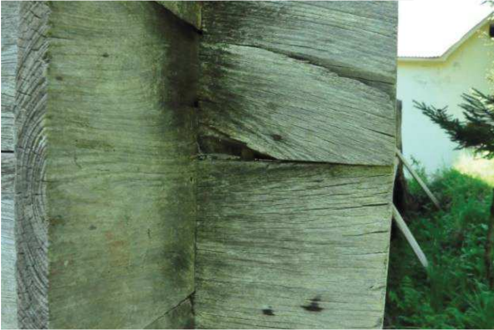
Resim 27240:Abdullah Kurukız Tekiri Geçme Tekniğindeki Ahşap Çivi
