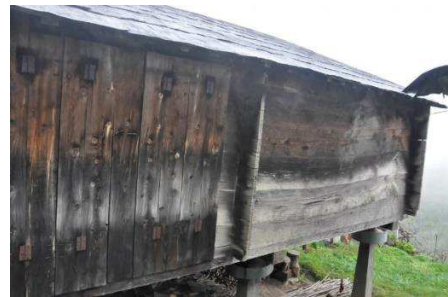
Resim 10: Yapının güney cephesinden görünüm
