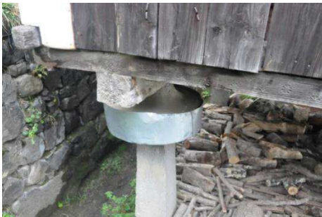
Resim 9: Metal sac ile kaplanmış ahşap aşak
