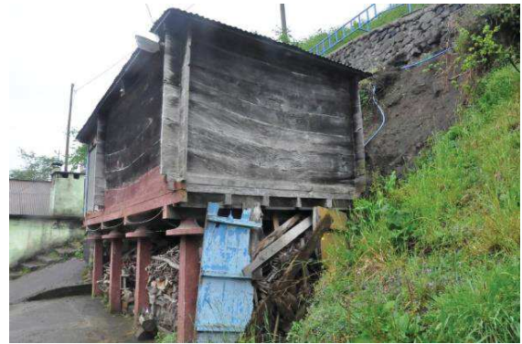
Resim 181: Ahşap Geçme Tekniği İle Yapılmış Hakkı Bektaş Tekiri
