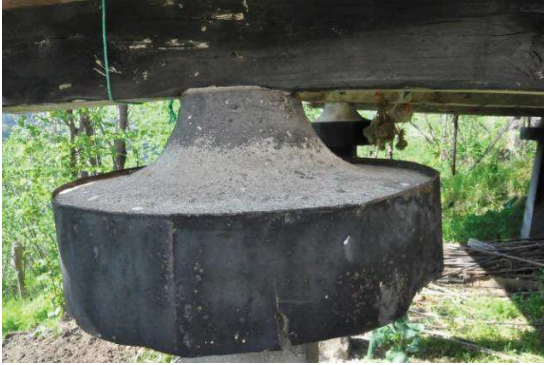
Resim 68: Akçiriş 25 Kapı Numaralı Tekir Teneke İle Kaplanmış Aşağı
