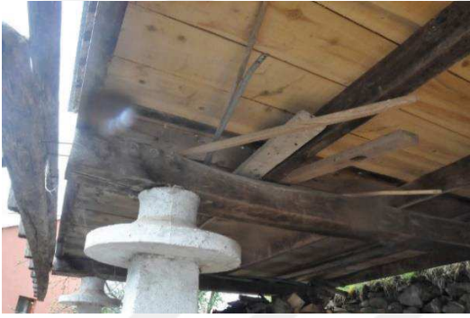
Resim 56: Muhammet Güner Tekiri Zemin Döşemesi Beton Ayağı ve Aşağı
