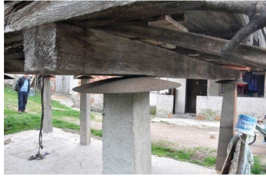
Resim 155: Sadık Köse Tekiri Beton Ayağı ve Sac Aşağı
