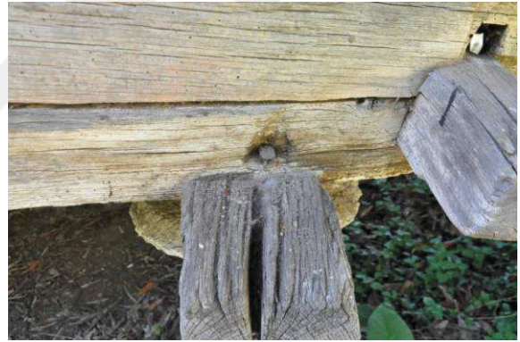
Resim 335: Ahmet Yılmaz Tekirinde Uzunluk Ağacı, Hatla El Yapımı Demir Çivi İle Tutturulmuştur
