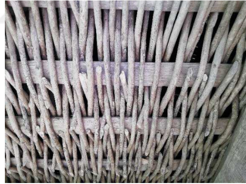
Resim 98: Kemal Kaya Tekiri Komar Ağacı Dallarıyla Yapılmış Zemin Döşemesi
