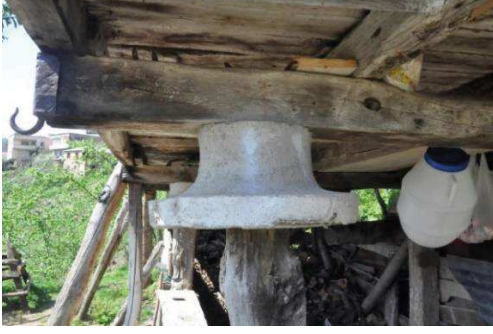
Resim 101: Selamet Cüre Tekiri Ahşap Ayağı ve Beton Aşağı
