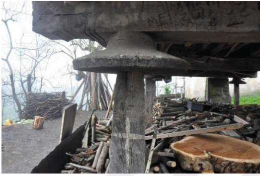
Resim 14: Bahri Metin Tekirinin ahşap ayak ve yuvarlak aşağından görünüm
